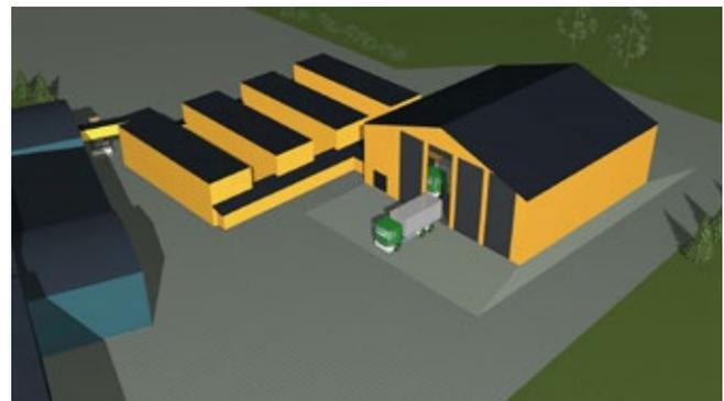
BioGTS® Biogas plant, feedstock 20 000 t/y, 55 t/d biowaste
